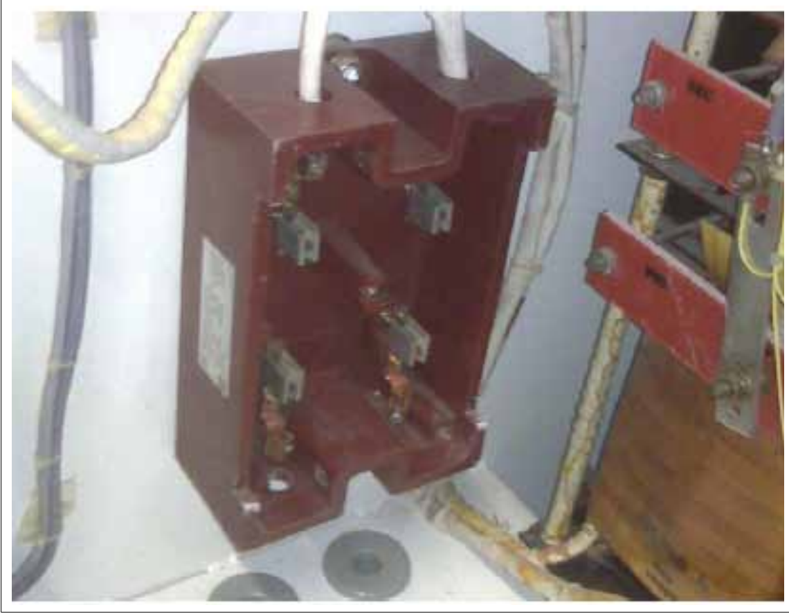
Şekil 5-3. Seri devre kesme cihazının mahfazası (kaynak: Liberty Airport Systems)
